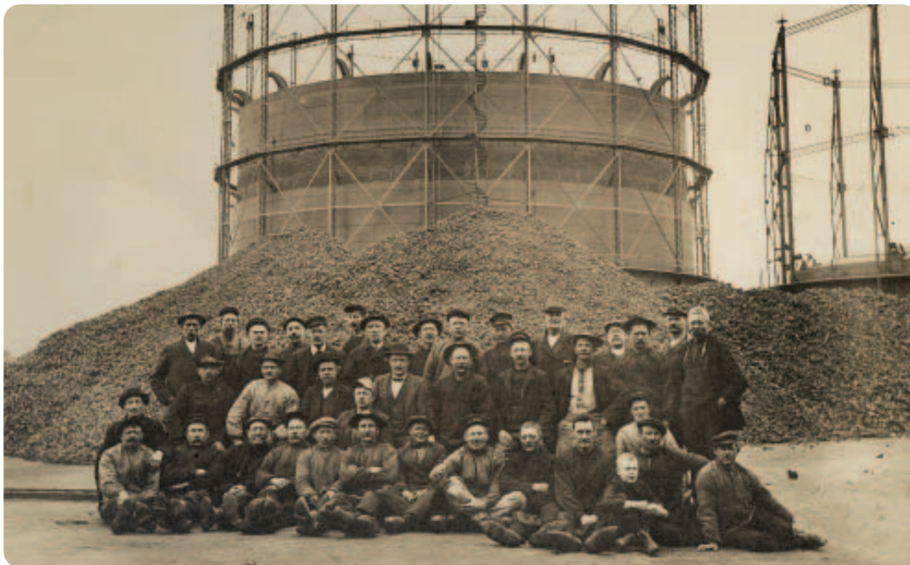
Nr. Sundby Gasværk 1907
